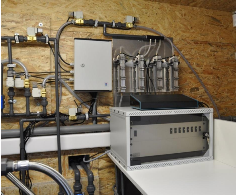
Slika 3: Pilotni sistem za čiščenje odpadne vode na Golniku z dnevno kapaciteto 3 m 3 .
