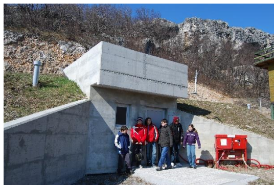
Slika 3: Vodohran pod Školom.
