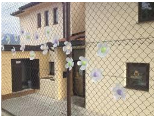
Slika 9: Energetska sanacija stavbe in kotlovnice podružnične šole Trnovo.
