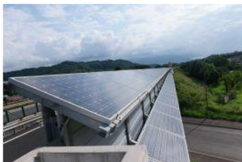
Slika 8: 648 m dolga sončna elektrarna ima 644 panelov, skupna površina znaša 1.082m 2 . (Foto: GO-TV).
